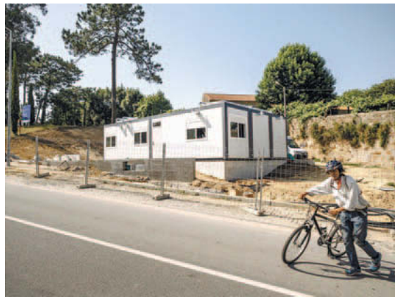
Sala está instalada e decorrem trabalhos finais
