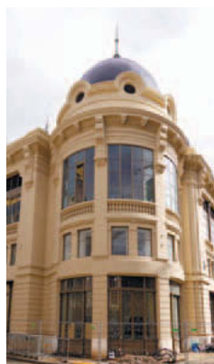
Obras no Bolhão começaram em maio de 2018
